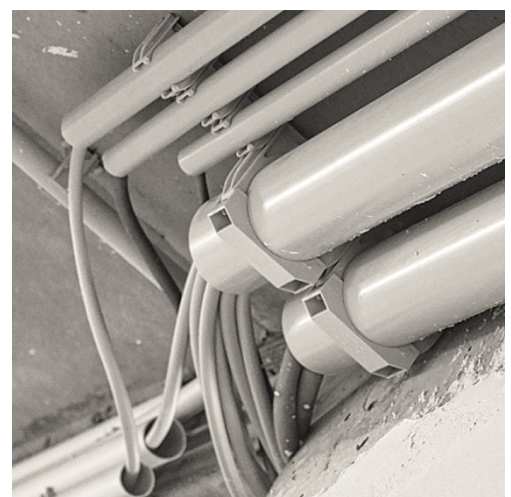
Mit dem UVB werden selbst Rohre mit schweren Kabelbündeln fest im EC Euro-Clip gehalten.
