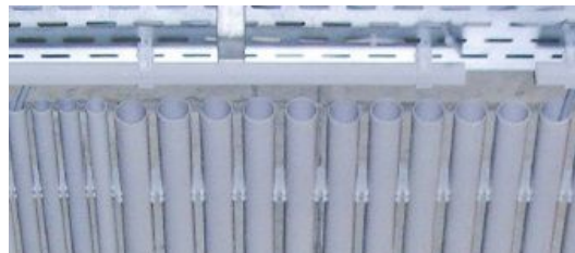
Durch das funktionelle Stecksystem werden mehrere EC Euro-Clips in unterschiedlichen Größen verbunden.
