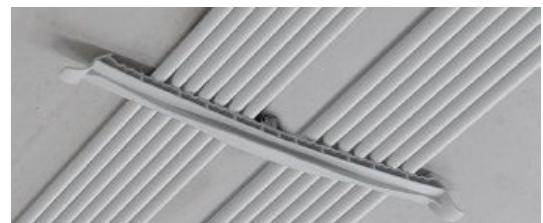
Für die trassenförmige Verlegung von Leitungsbündeln sind die KB Kabelbügel entwickelt worden.
