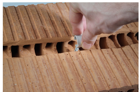
Einfach clever: Die integrierte Nase an der Innenseite der Schelle erlaubt das Spannen des Schlauches zwischen zwei Schellen - für einen leichteren Kabeleinzug.
